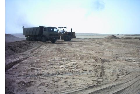
Loading Fill Material
