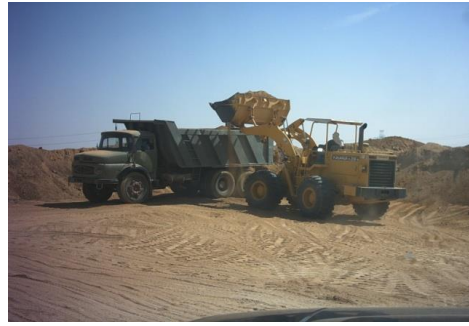
Loading Fill Material
